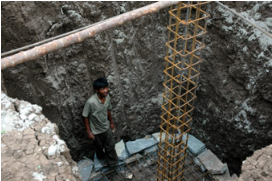
Realització de les obres de fonamentació del centre
