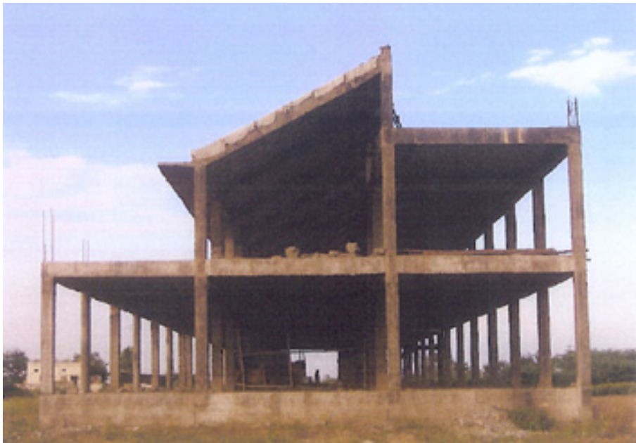
Finalització de la segona fase, estructura del centre
