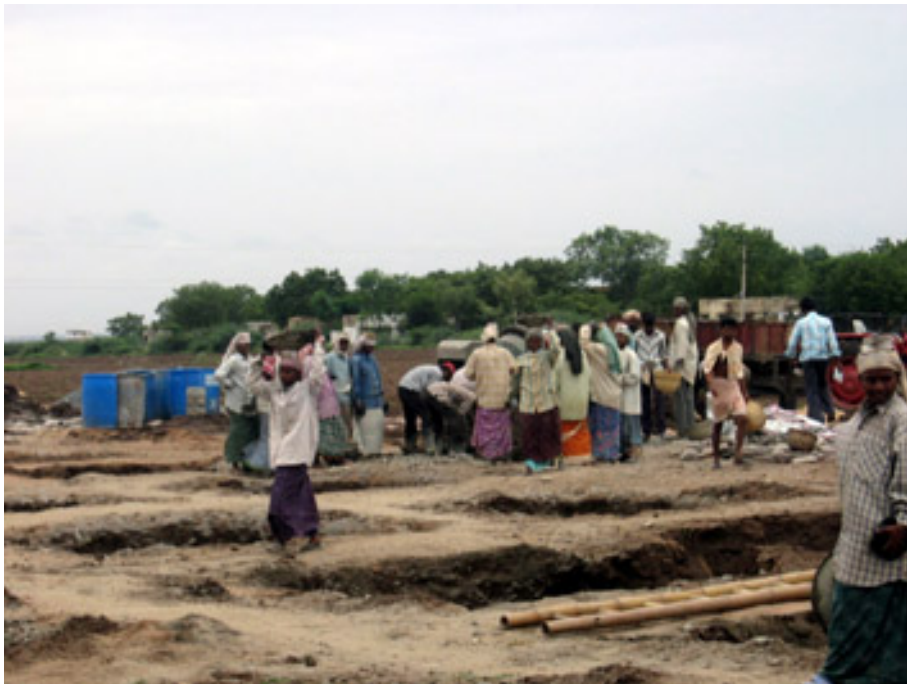
Equips de treballadors a les obres
