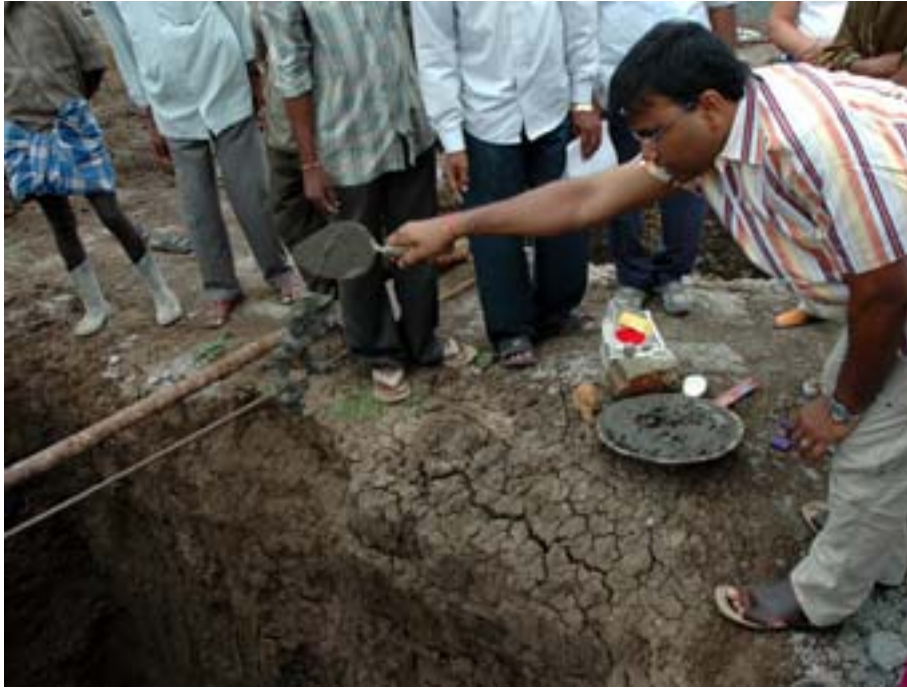
Inauguració de la fonamentació de les obres de construcció del centre
