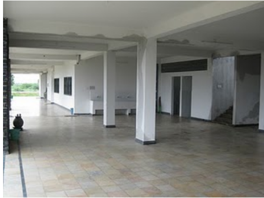
Hall de distribució central i porxada passadís
