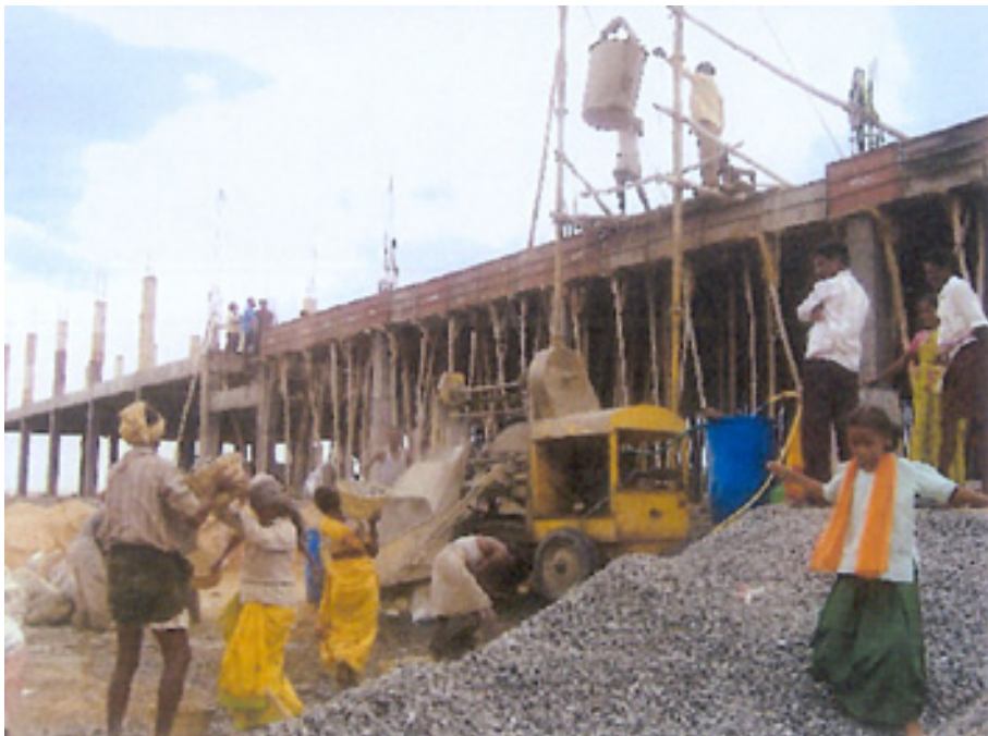
Fonaments i construcció de l'estructura
